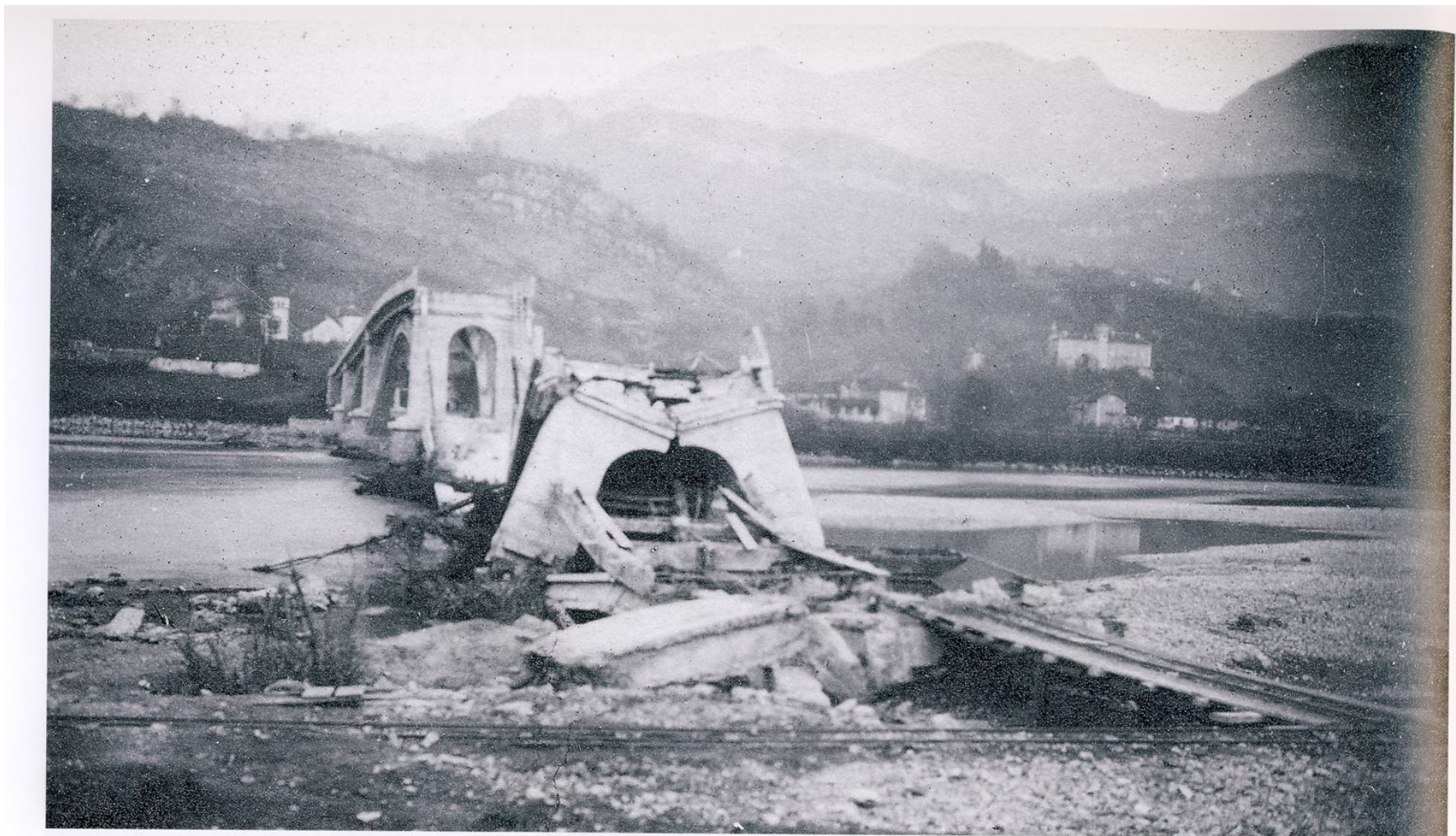
Le pont de Lucey détruit.
